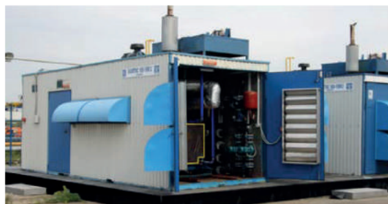
Рис.4. Комбинированная энергоустановка на базе ДВС
